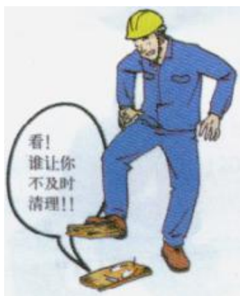
图 11.7.16 及时清理木模板上的铁钉
