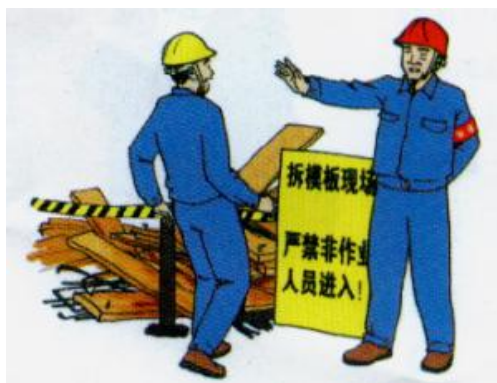
图 11.7.14 拆模板现场
