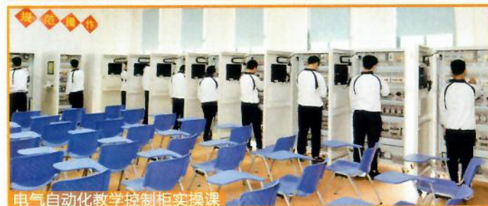
电气自动化教学控制柜实操课
