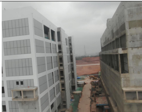
变电站北侧-园区数据设备大楼
