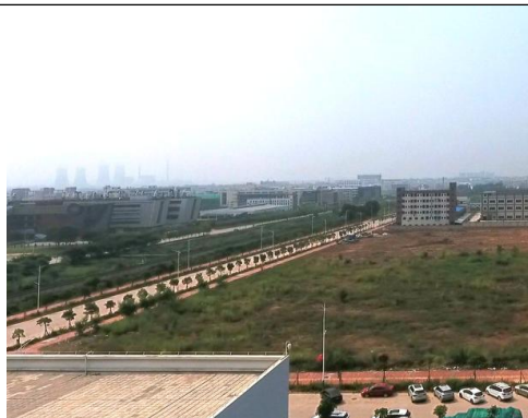
站址南侧-平整地块
