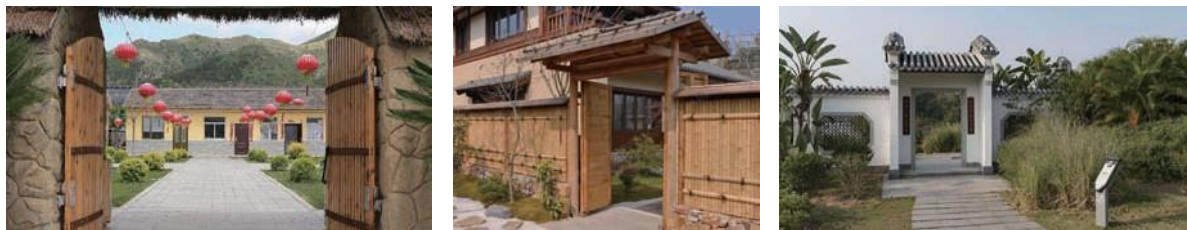
本土材质的建筑围墙
