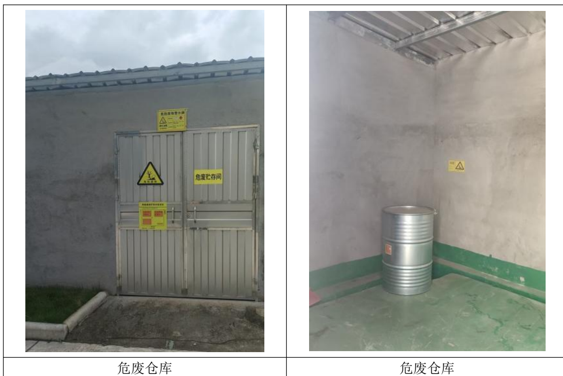
图 3.4-1 迁扩建前项目现状及环保措施图片
