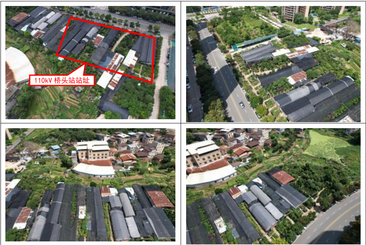
拟建 110kV 桥头站
